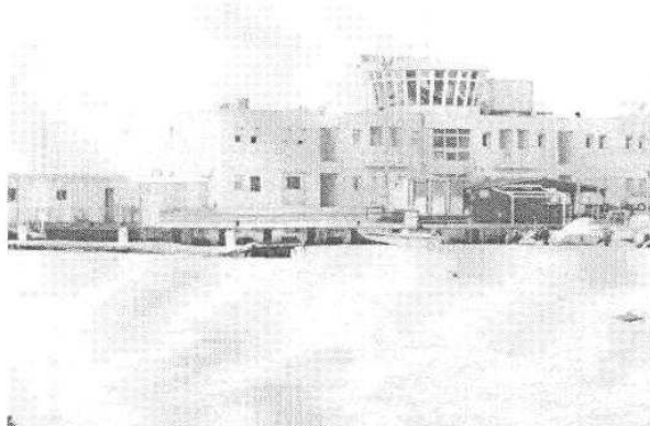
Passi avanti per la messa in sicurezza del porto
